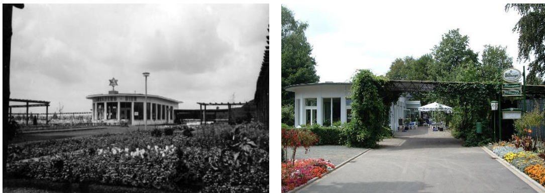
Abbildung 5: Das ehemalige Restaurantgebäude mit prägendem Rundbau
