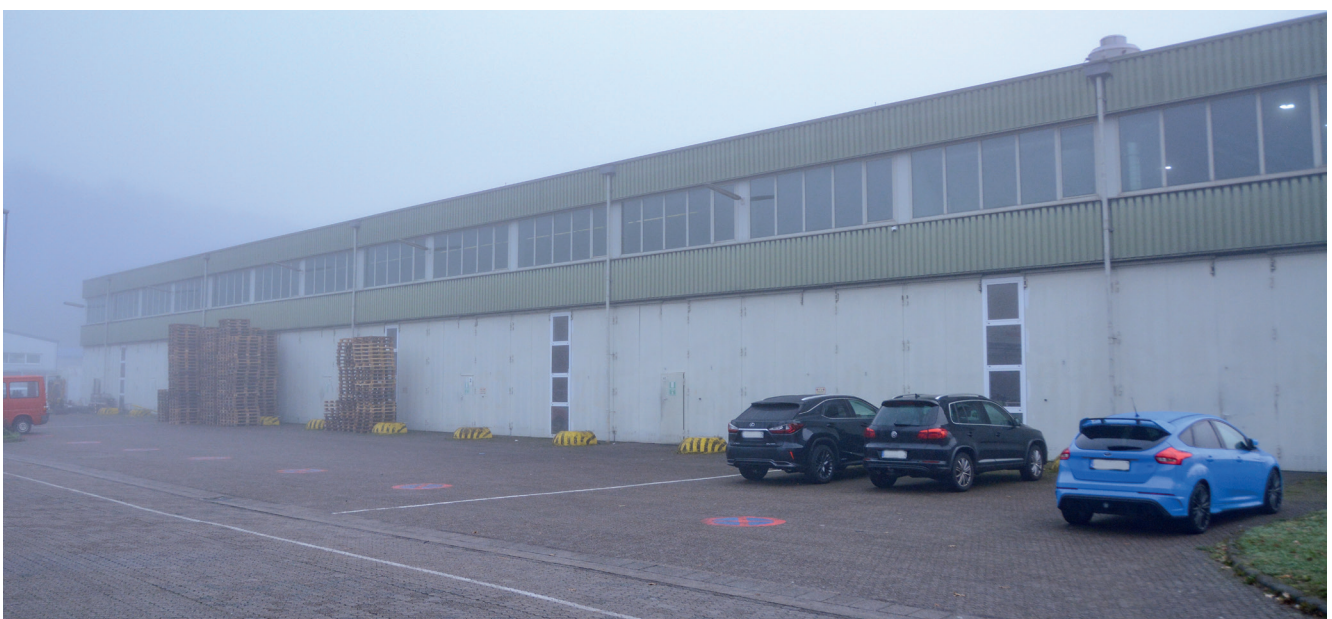
Blick auf die bestehende Gewerbehalle im Saarpfalz-Park von Südwesten
